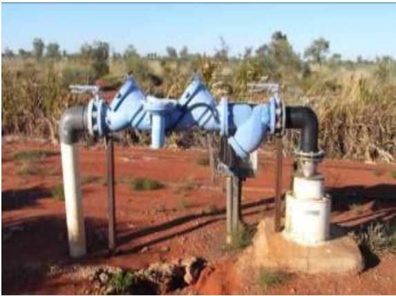
Hình 1 – Thiết bị RPZD, hình chụp DEPWS
