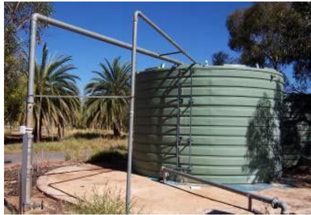
Hình 2 – Thiết bị Air Gap qua thùng chứa nước, hình chụp DEPWS
